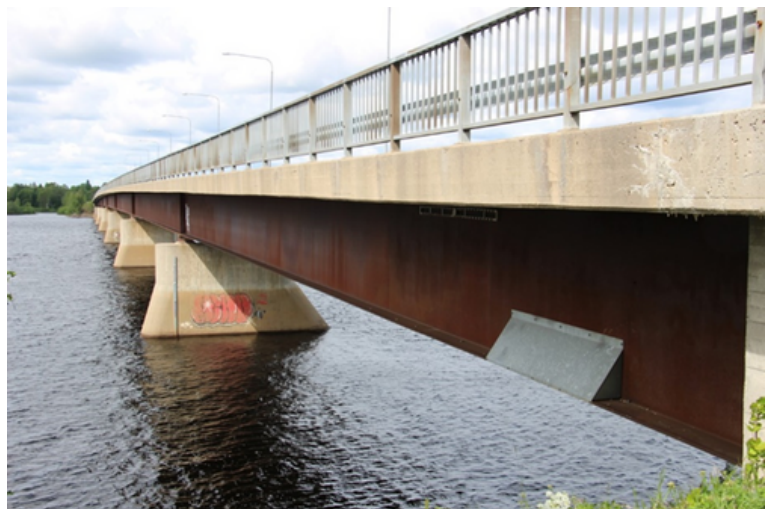
Kemijoen ylittävä Tervolan silta on Suomen pisin säänkestävästä teräksestä valmistettu silta. Silta on 494 metriä pitkä ja se on rakennettu 1975.
