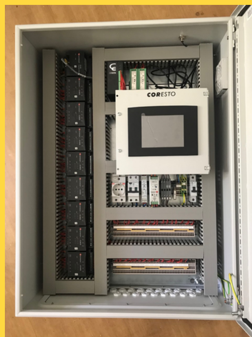
MoCo RCM prosessoripohjainen mittausyksikkö asennettiin parkkihallin tekniseen tilaan.
